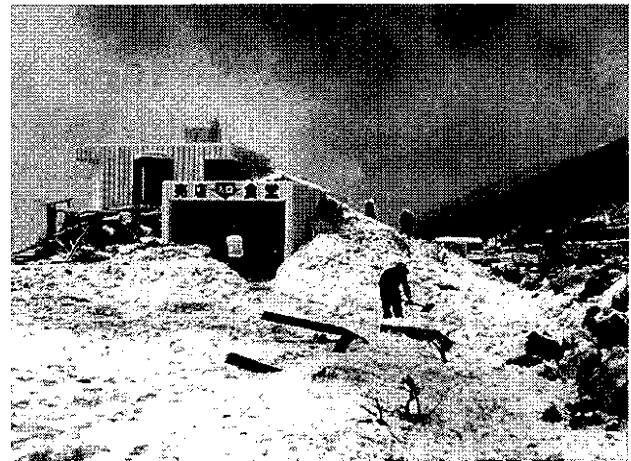
図7 富士山スラッシュ雪崩被災状況 (2007年4月10日撮影) 富士山五合目レストハウスの埋雪状況
